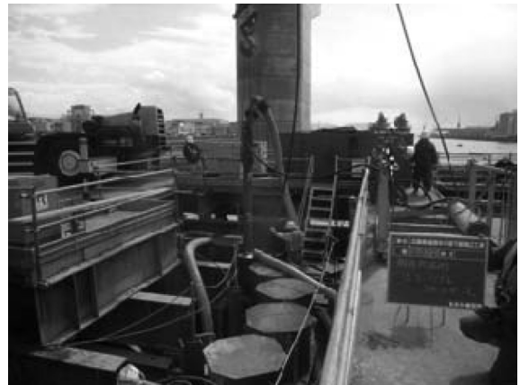
図-4 エアリーフト施工状況
