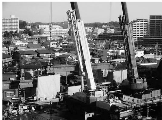
図-1 大型クレーンによる合吊解体状況
