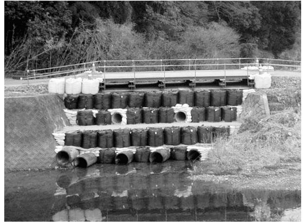
図-4 工事用道路（河川横断）設置
