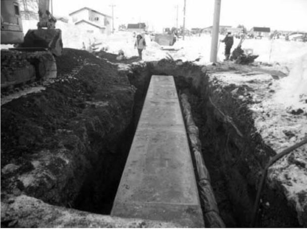
図-4 縦断管と水道管
