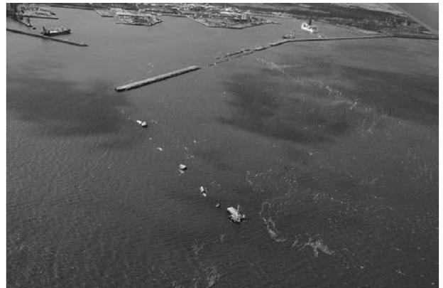
図-2 防波堤被災状況（提供：八戸港湾・空港整備事務所）
