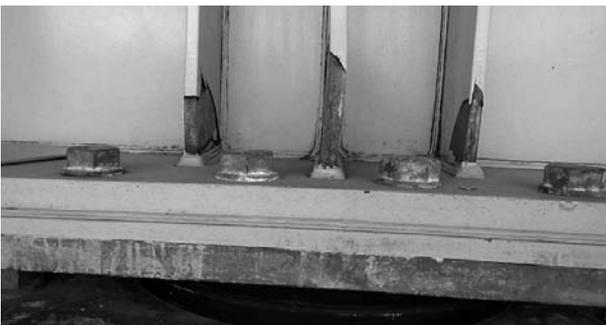
図-3 支点上補剛材の変形状況
