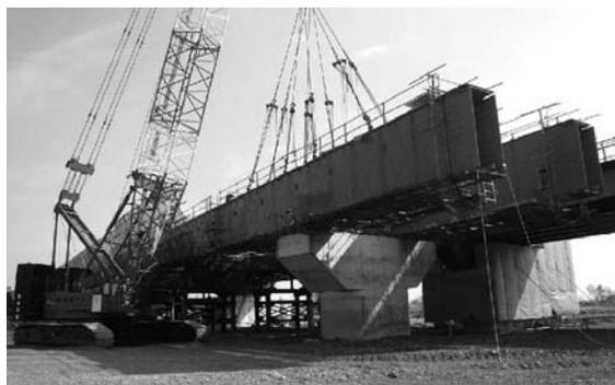
図-5 主桁架設状況
