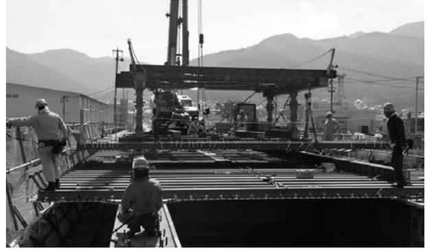
図-4 台車設備による合成床版の設置状況
