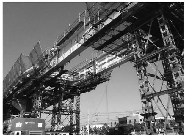
図-5 調整桁架設
