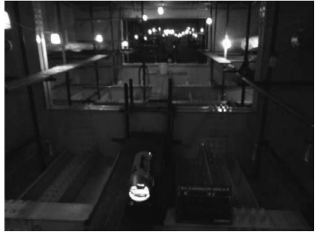
図-12 現場塗装工寒中養生状況
