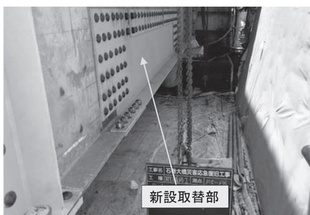
図-9 損傷部への新設部材設置完了
