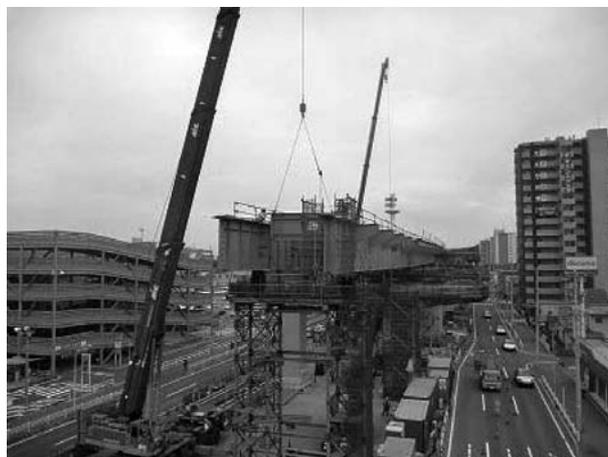
図-1 鋼桁架設状況
