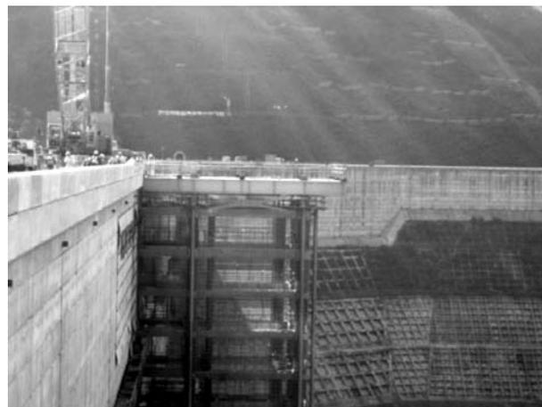
図-7 塔上ガーダ据付完了
