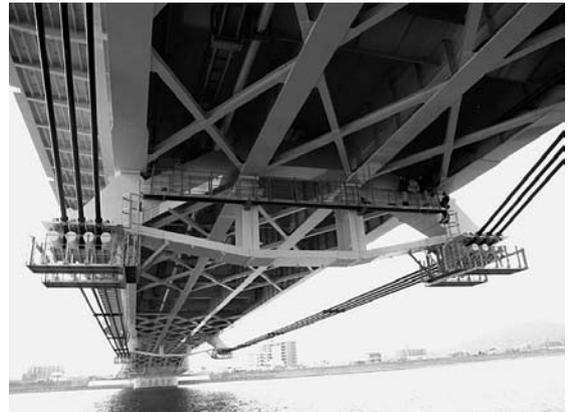
図-6 下サドルケーブル設置状況
