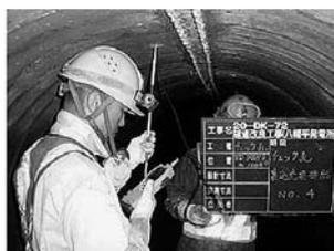
図-3 内視鏡による充填確認
