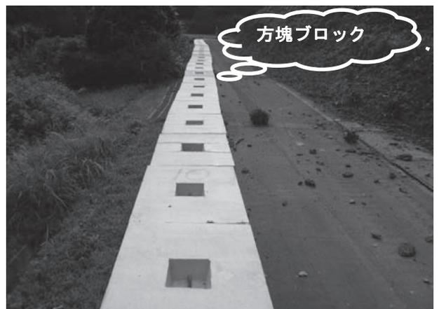
図-8 方塊ブロックの設置
