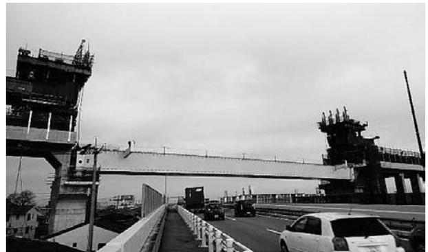
図-9 桁降下完了
