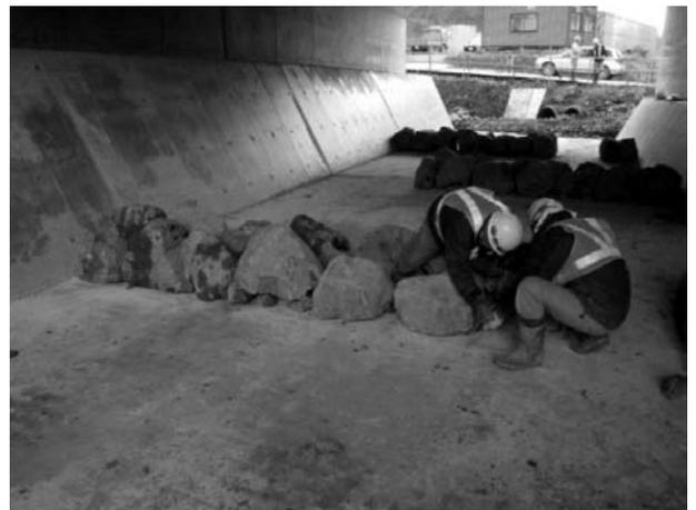
図-9 帯工据付状況
