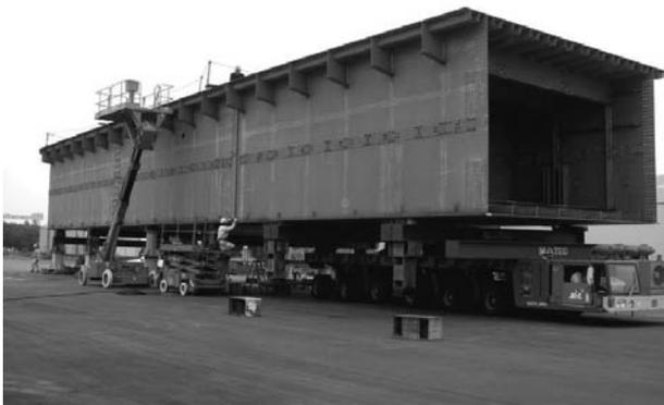
図-8 箱断面ブロック運搬・仮組状況
