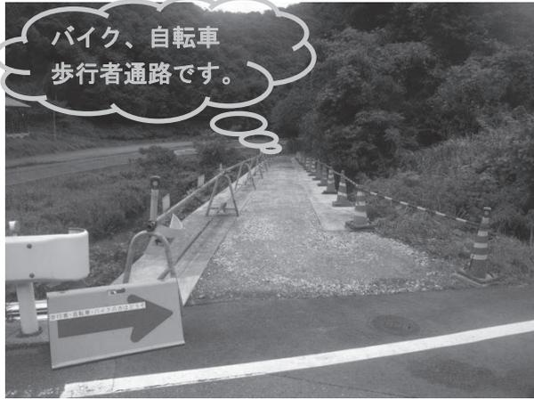
図-5 迂回路設置完了
