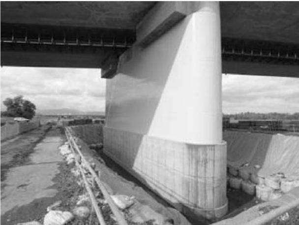
図-9 P-5橋脚耐震補強完了
