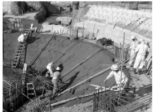
図-3 均しコンクリート打設状況
