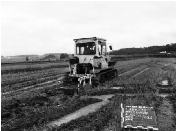
図-3 機械による水切り作業
