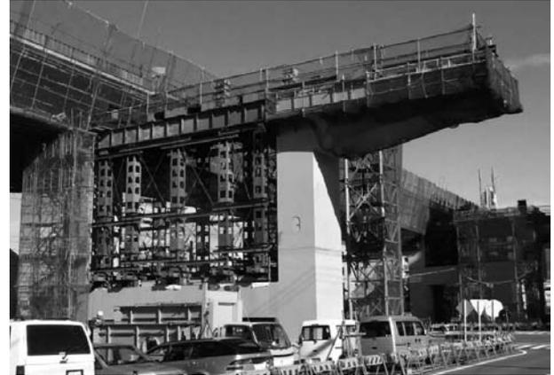
図-3 横取り専用支保工設置
