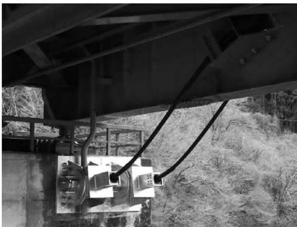
図-3 落橋防止装置設置状況
