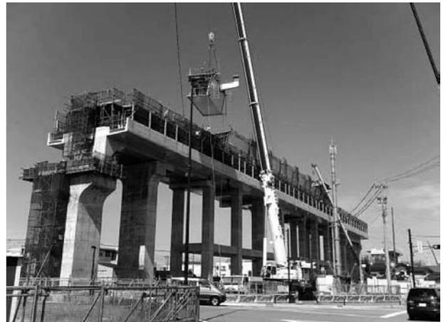
図-4 桁組立状況
