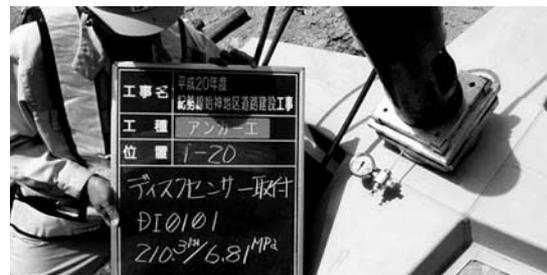
図-5 荷重計の設置
