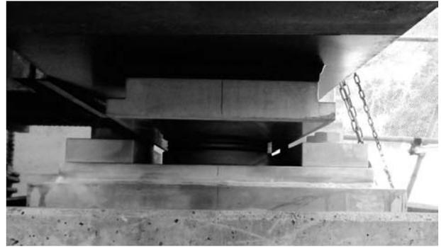
図-6 ベースプレートを追加した鉛直支承 (完成時)
