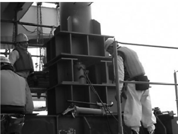
図-6 台船上での反力調整
