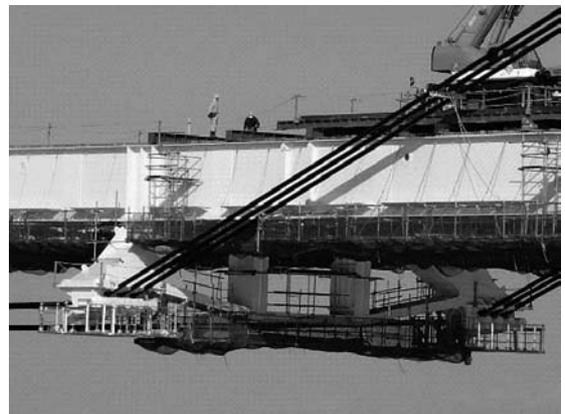
図-16 本ケーブル架設完了
