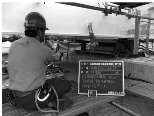
図-3 P4支承固定時桁温計測状況
