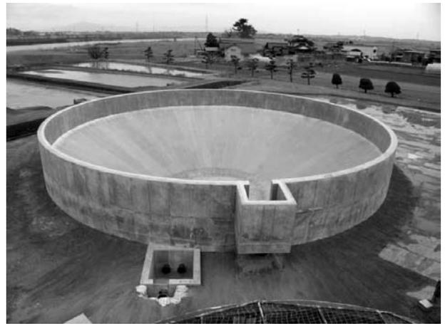
図-2 No.4高速凝集沈殿池完成全景
