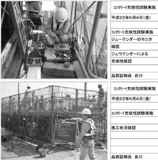
図-4 実物大供試体にて充填性確認
