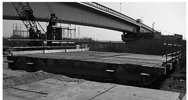
図-3 クレーン構台設置状況
