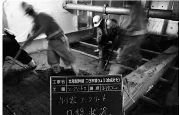
図-13 制振コンクリート打設状況
