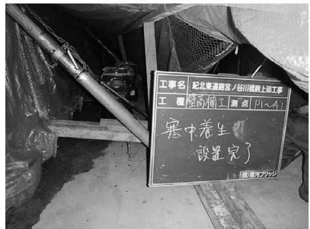
図-5 壁高欄養生状況
