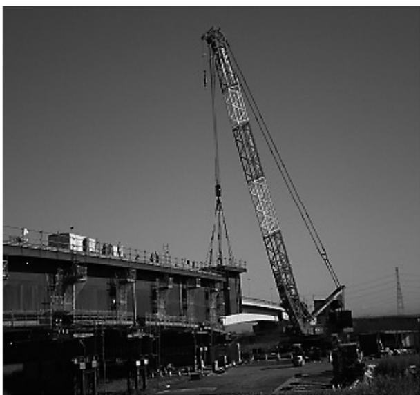
図-4 横取り架設前の桁架設状況
