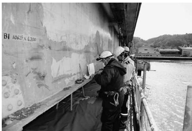
図-2 主桁損傷の調査状況
