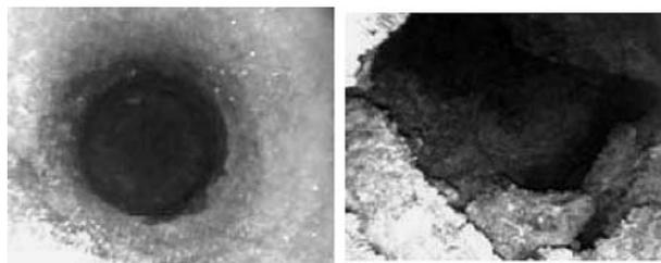
図-4 ウレタン充填確認状況 図-5 未充填(空洞有り)
