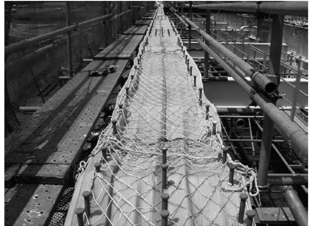
図-7 桁の冷却状況
