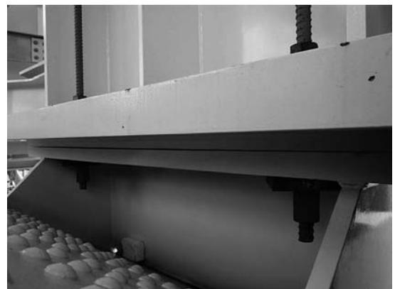
図-7 下サドル横桁接合部
