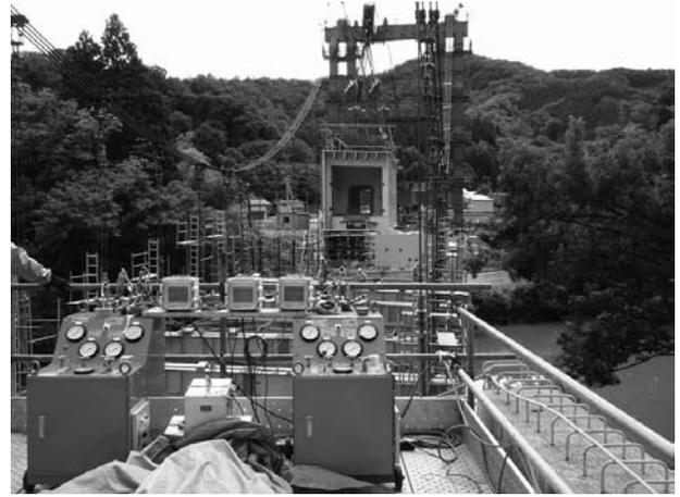
図-3 油圧調整装置
