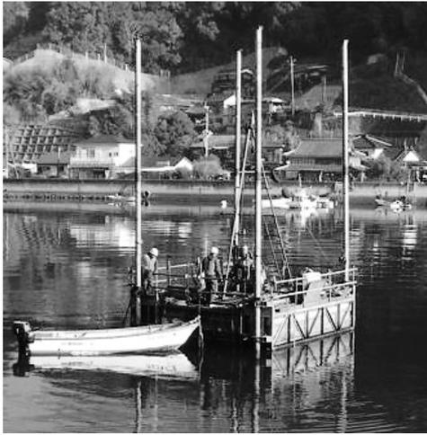
図-3 スパット台船によるチェックボーリング
