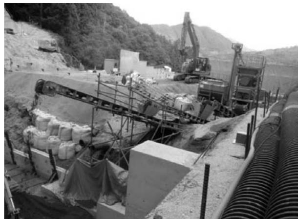
図-7 ベルトコンベアによる運搬
