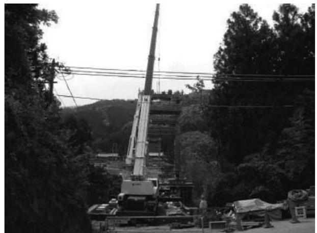
図-4 60t吊りホイールクレーンによる右岸側鉄塔組立
