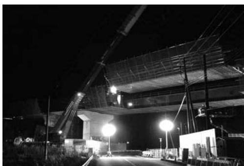
図-6 県道上のブロック架設状況
