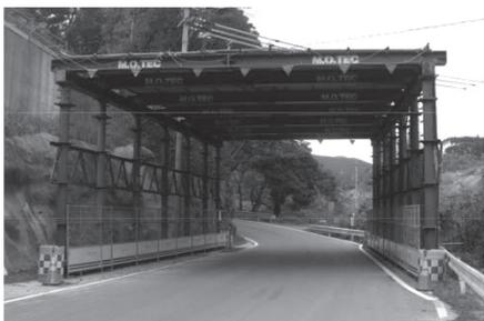
図-12 県道防護設備の構造と設置状況
