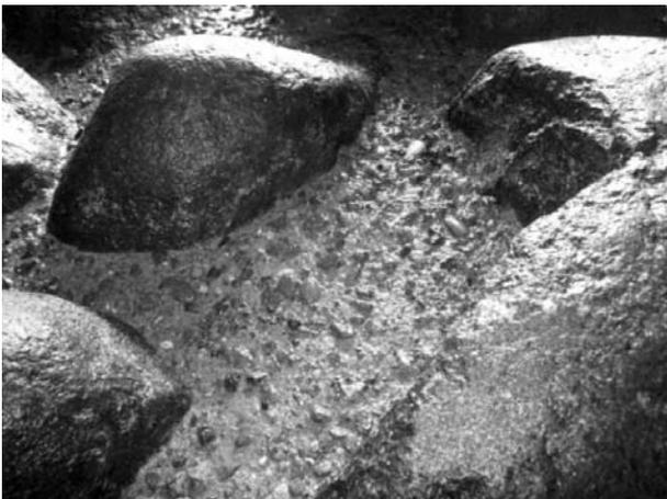
図-11 流路部洗出し状況
