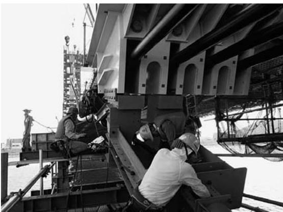
図-15 斜ケーブル引込み状況
