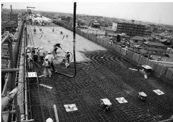
図-12 床版コンクリート打設状況
