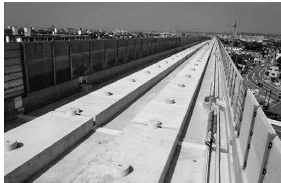
図-14 路盤コンクリート完了
