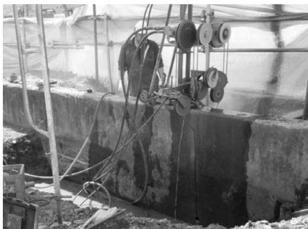
図-6 ワイヤソーによる切断
