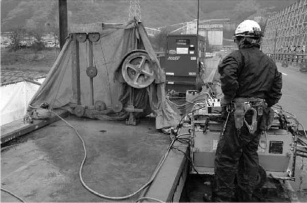
図-2 ワイヤソーによる合成床版切断作業
