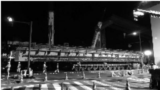
図-4 多軸式運搬台車運搬状況
