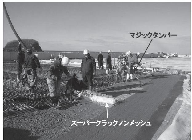
図-5 コンクリート打設状況
