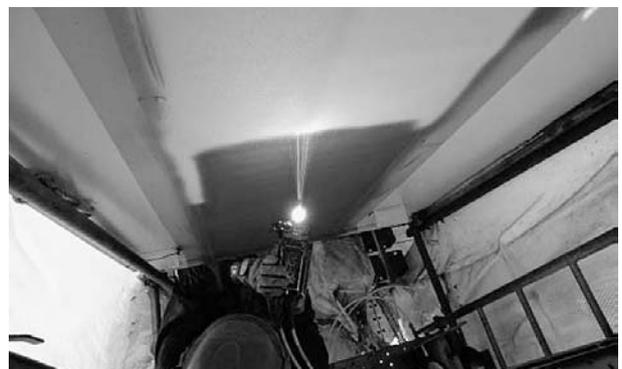
図-5 亜鉛・アルミ常温溶射
