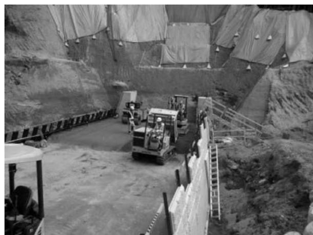
図-8 不整地運搬車による運搬
