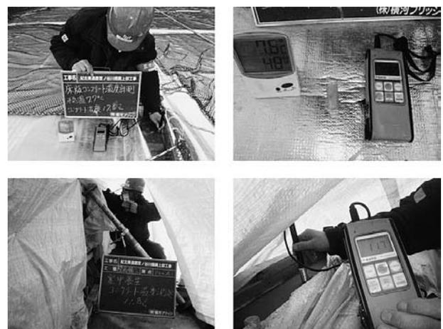
図-6 コンクリート温度計測状況
