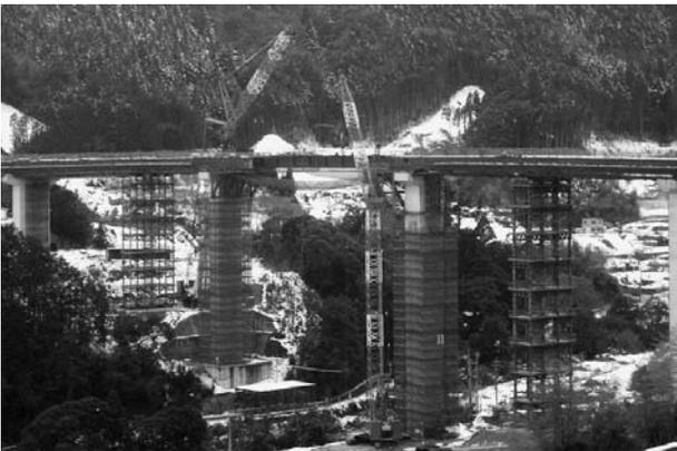
図-1 落とし込み架設状況
