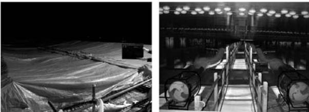
図-11 コンクリート寒中工養生状況
