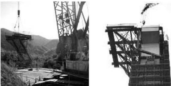
図-8 斜ベント架設・設置状況
