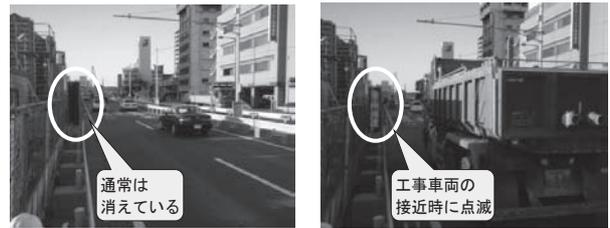
図-4 電光掲示板による一般車両への注意喚起状況
