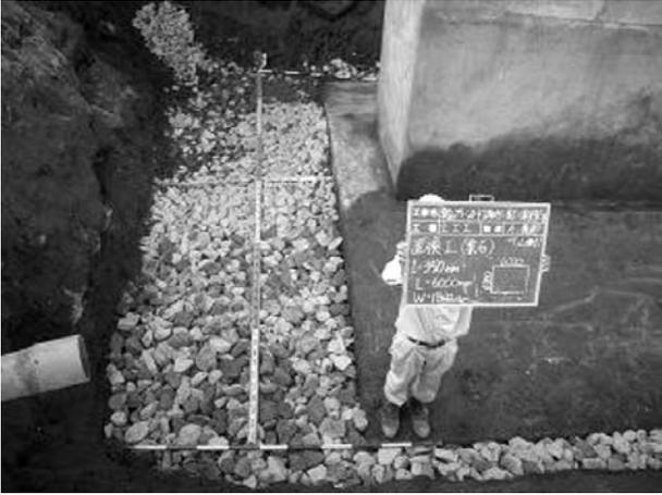
図-8 軟弱地盤層栗石置換工
