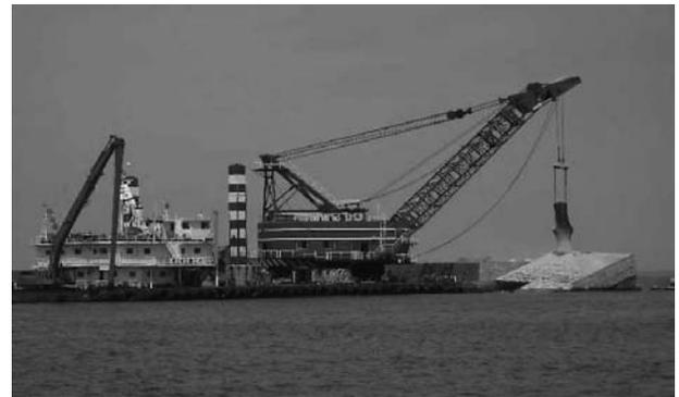
図-12 砕岩棒刃先制御治具を用いたケーソン破砕状況
