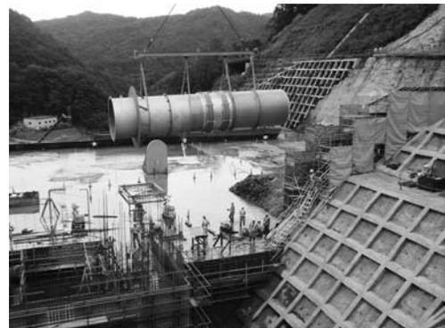
図-5 吊込作業（天秤使用）
