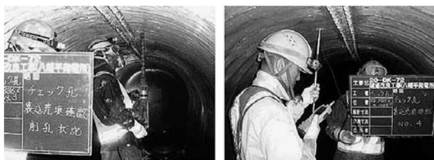
図-2 注入孔削孔状況
