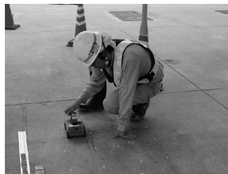
図-3 鉄筋探査状況
