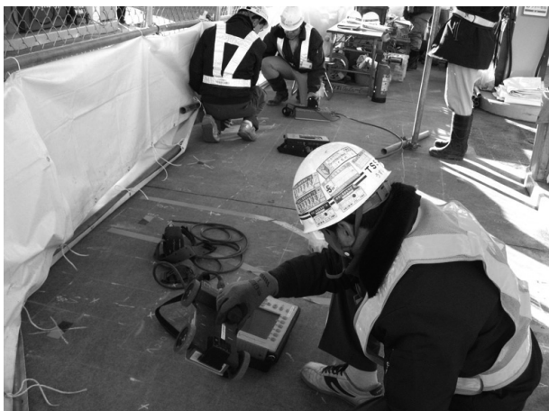
図-4 コンクリート内部探査状況
