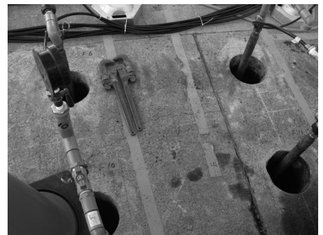
図-2 土壌改良状況
