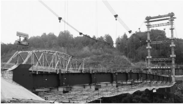
図-6 補剛桁架設状況
