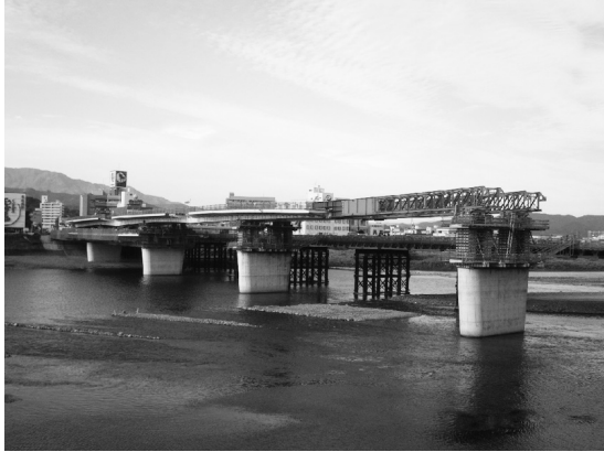
図-2 送出し架設状況
