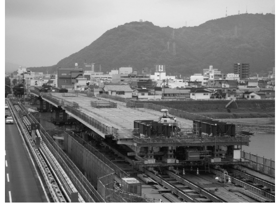
図-2 送出し架設状況
