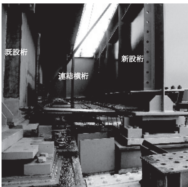
図-8 現地施工状況 (工事 A)
