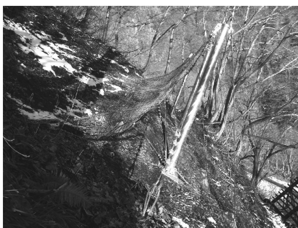
図-8 C工区 三角フェンス完成写真
