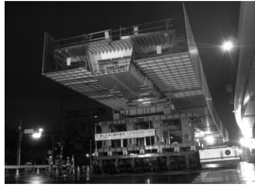
(b) 送り出し架設中
