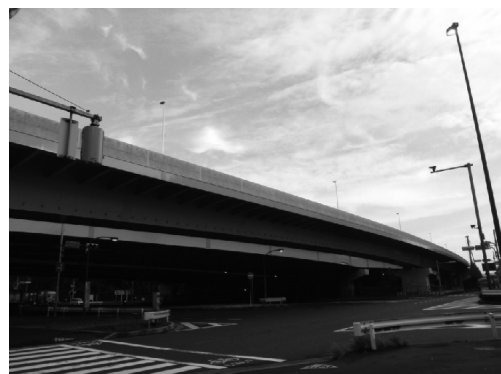
(f) 完成写真
