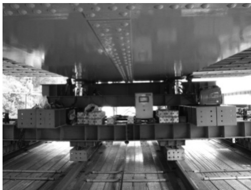
(c) リアルタイム計測設備
