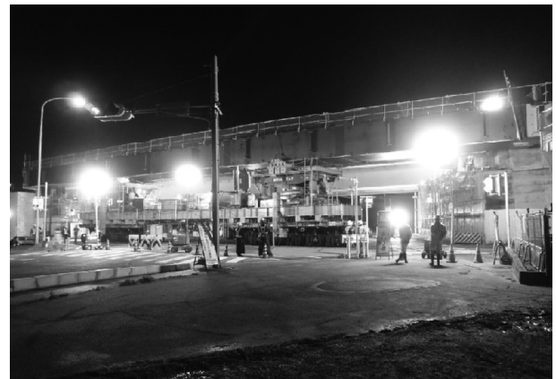
図-8 大型自走式キャリアによる架設
