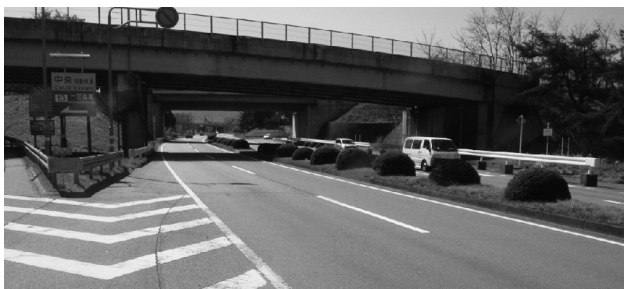
図-2.2.3 工区後半の曲線部
