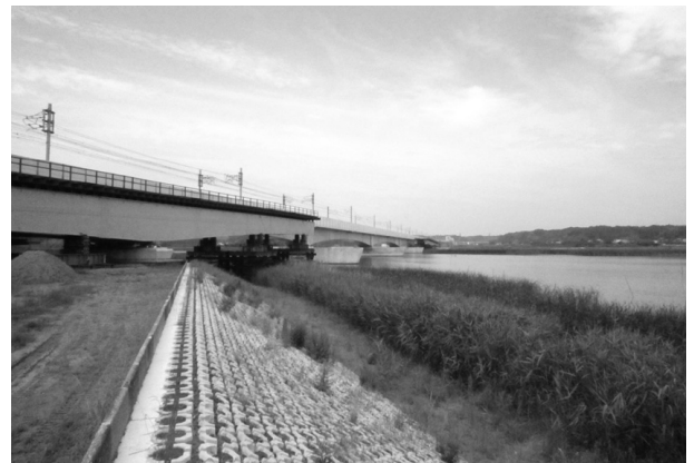
図－2 着手前現場全景
