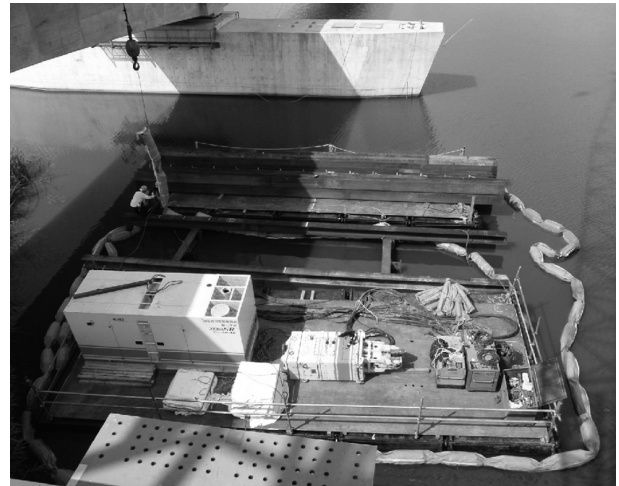
図-3 シルトフェンス設置状況
