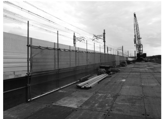
図-6 営業線側の防護柵設置状況
