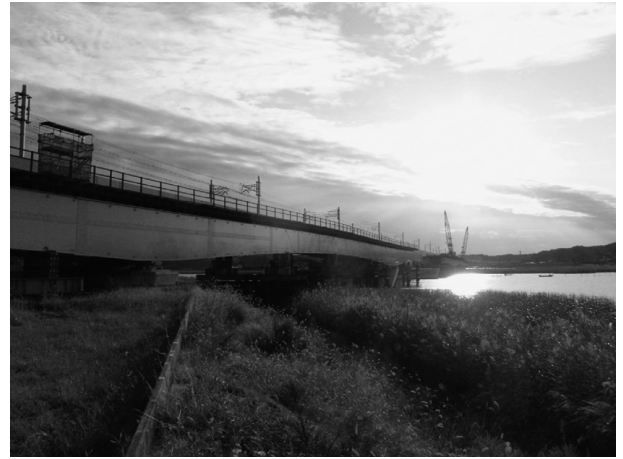
図-9 現場完成全景
