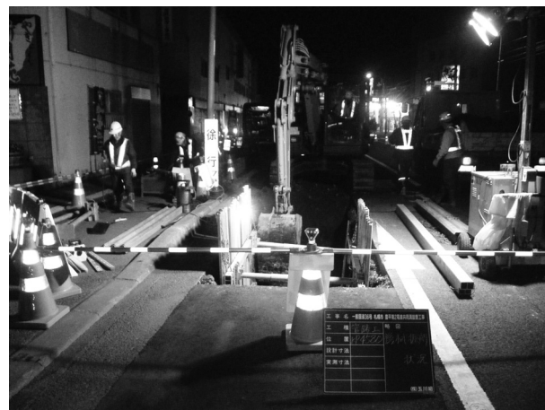
図-5 管路掘削状況
