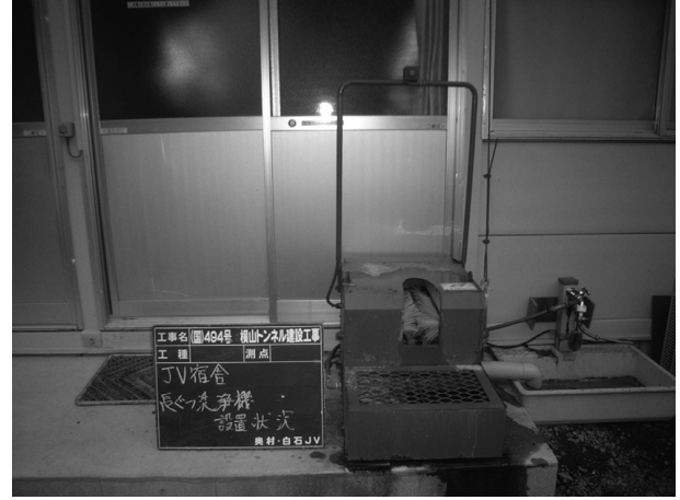
図-4 作業靴洗浄設備
