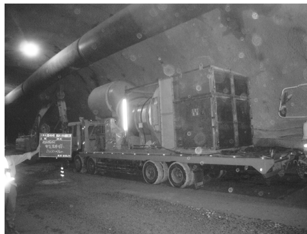
図-2 電気集塵機
