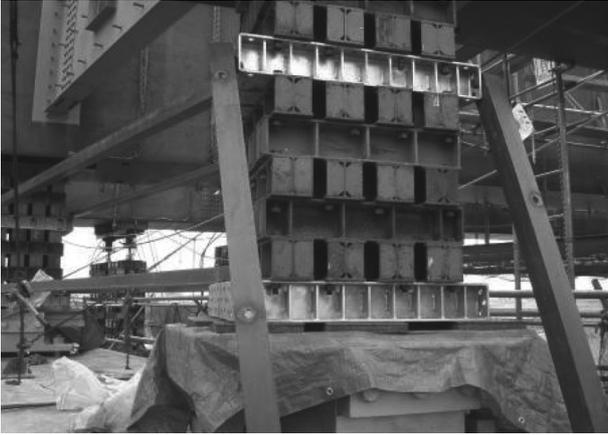
図-8 サンドル固定用鋼材の増設
