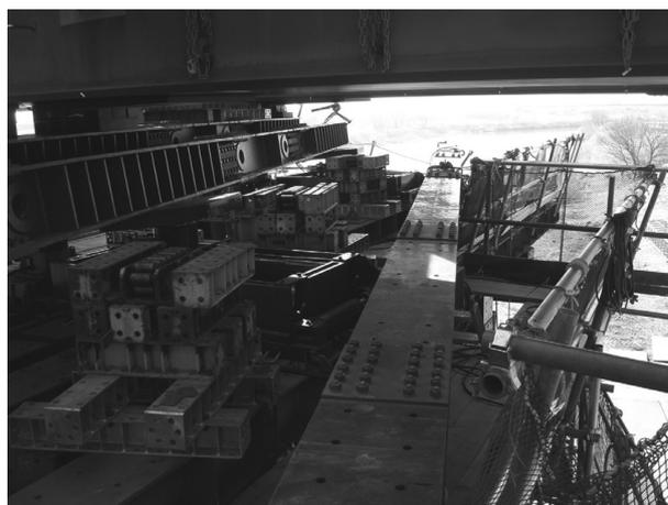
図-7 工事用梁の落下状況
