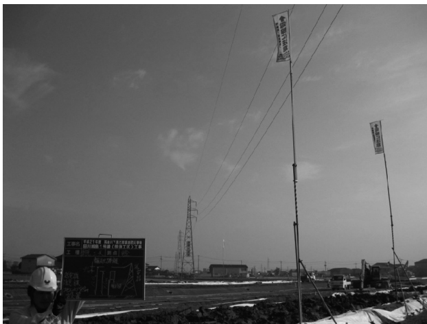
図-8 離隔高さ明示旗設置
