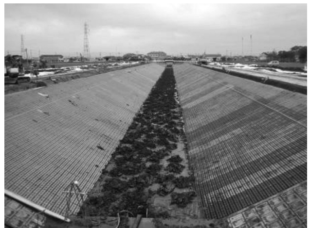
図-2 ブロックマット・水路内覆土完了
