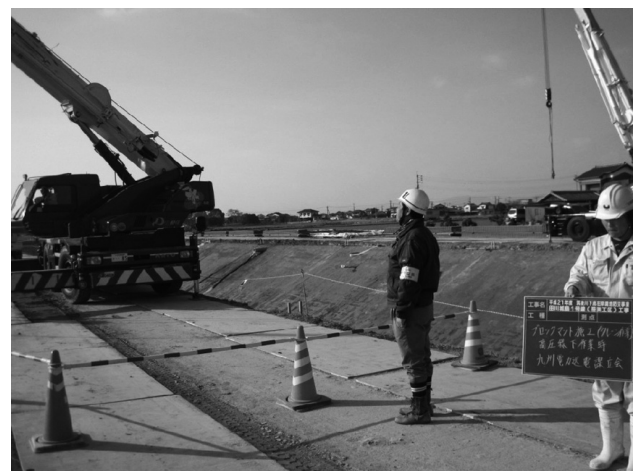
図-10 送電線下での専任監視員配置 九州電力（大牟田送電課）見張員立会
