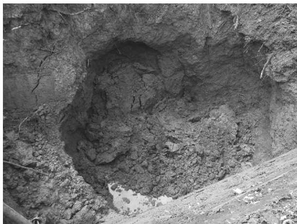
図-3 湧水・崩土箇所確認
