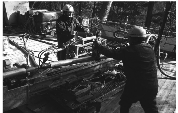
図-6 取付け状況
