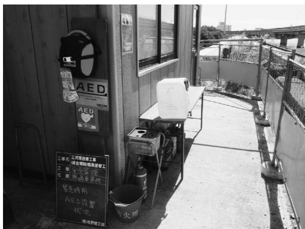
図-3 現場事務所にAEDの設置
