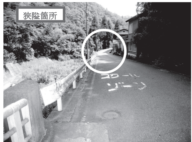
図-1 着手前県道状況
