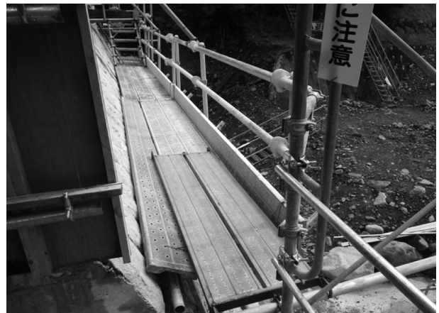
図-8 足場の隙間養生状況
