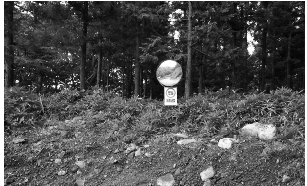
図-7 カーブミラーの設置
