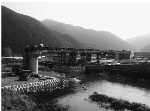
図-4 補剛桁架設完了
