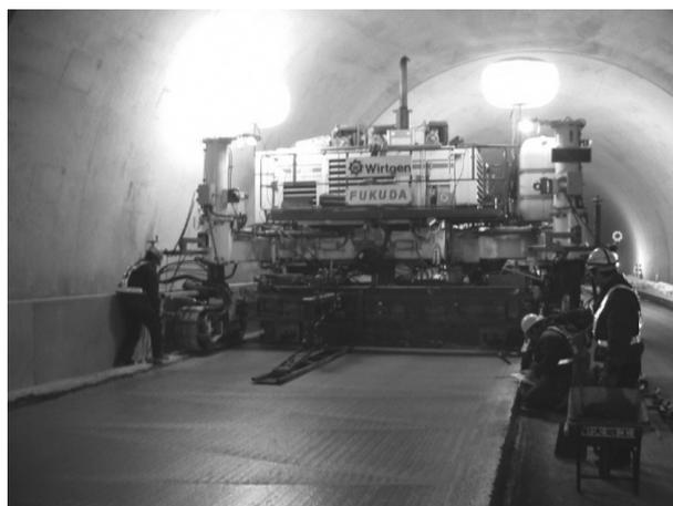
図-9 コンクリート舗装打設状況
