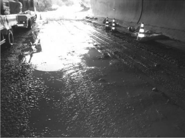
図-3 泥濘化したトンネル坑口付近の通行帯
