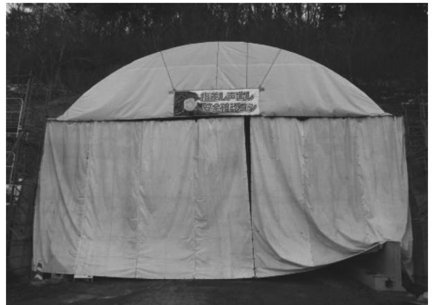
図-4 トンネル坑口の閉鎖 (閉鎖時)
