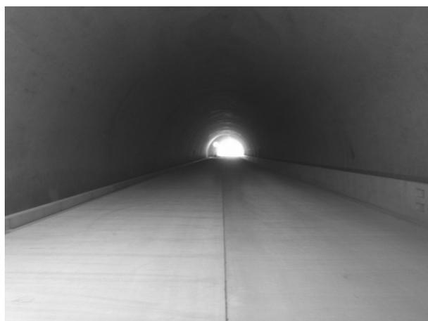
図-10 コンクリート舗装打設完了
