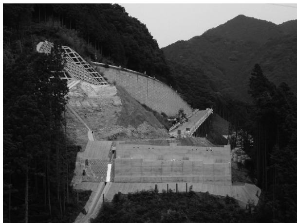
図-1 工事施工箇所全景
