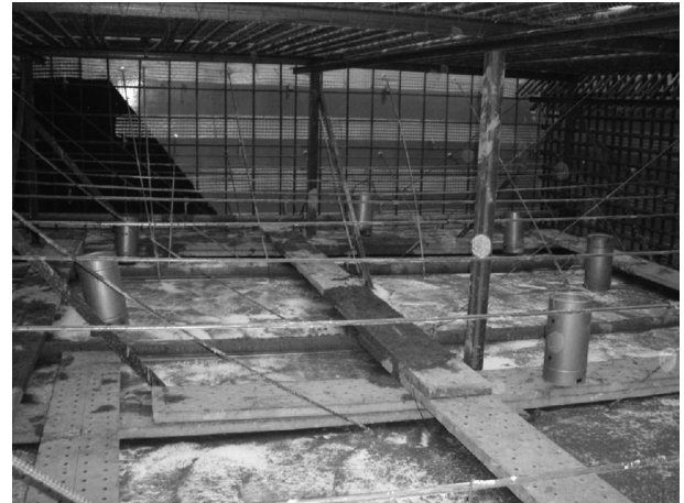
図-5 打継処理剤散布状況
