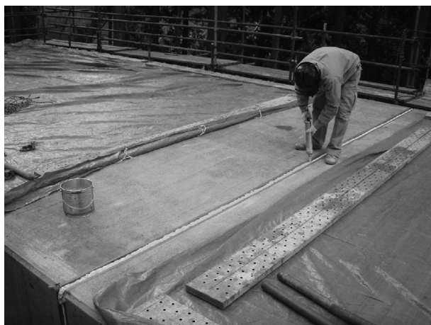
図-8 Vカット目地充填状況
