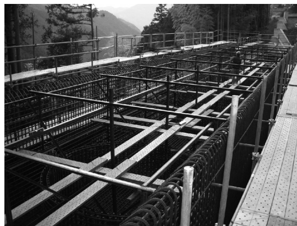
図-4 鋼材配置完了
