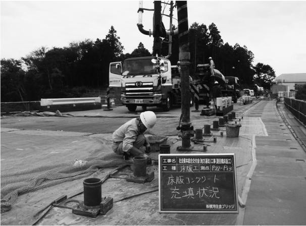
図-2 コンクリート充填状況（充填孔）
