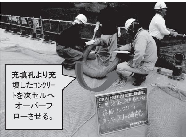
図-3 コンクリート充填状況（排出孔）
