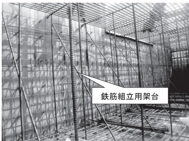
図-2 鉄筋組立用架台設置状況
