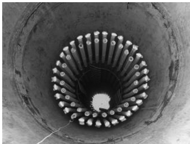
図-5 鉄筋建込完了
