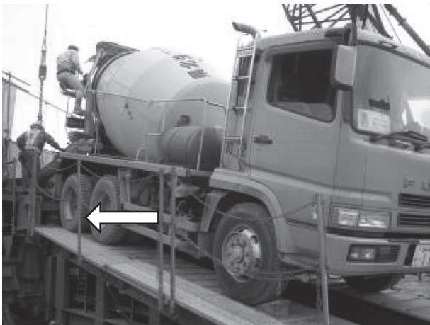
図-7 本体とスロープとの段差
