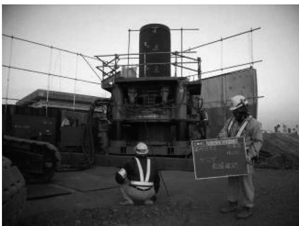
図-4-1 下げ振りによる鉛直確認
