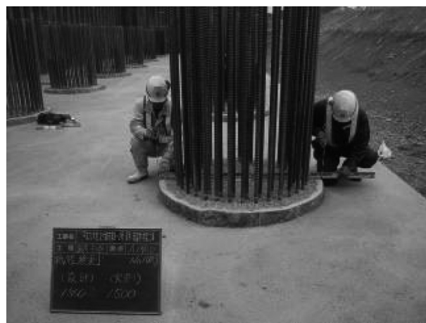
図-6 場所打ち杭完了
