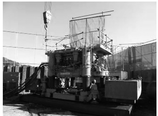
図-3-2 掘削機セット完了
