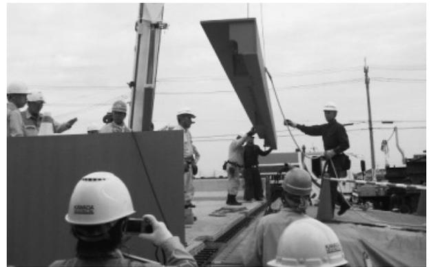
図-13 仮設鋼床版架設（模擬訓練）
