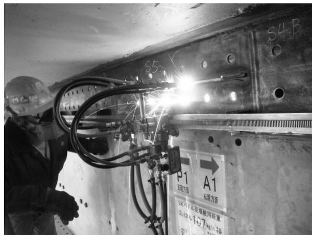
図－4 ガス切断状況
