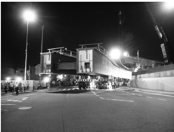
図-3 大型自走台車による運搬
