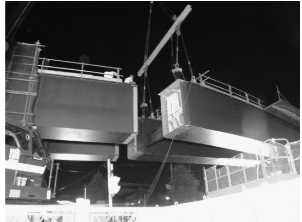
図-4 2主桁連結時の仕口合せ
