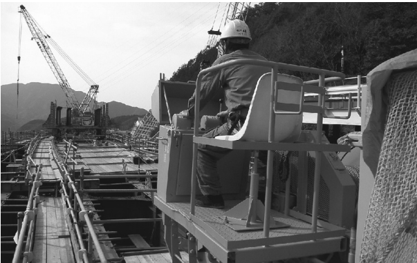
図-11 ウィンチによる逸走防止
