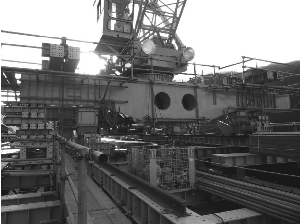
図-6 トラベラクレーン据付状況
