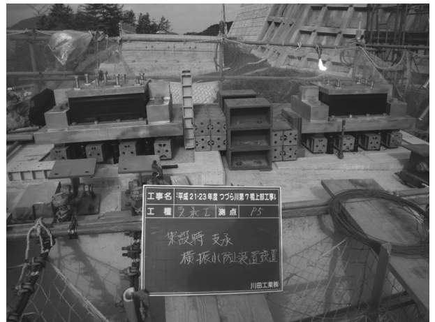
図-9 支承横振れ防止装置
