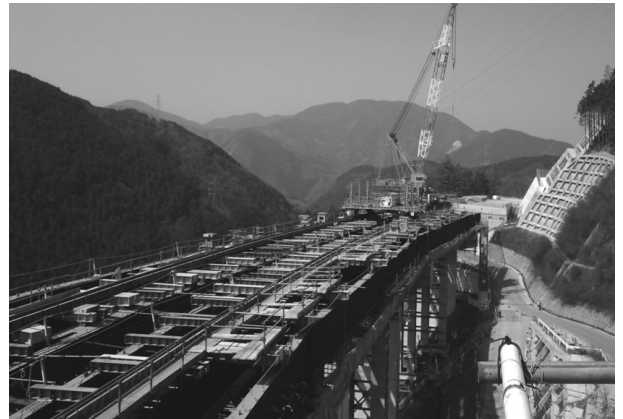
図-8 軌条梁・軌条受梁・反力架台設置状況
