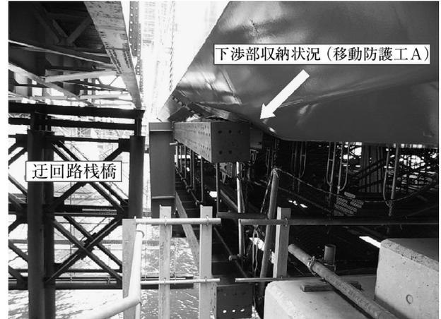
図-14 移動防護工A張出部収納状況
