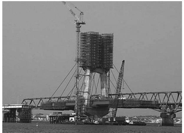
図-4 バランシング架設状況
