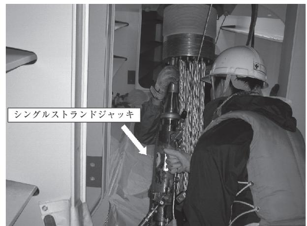
図-8 ケーブル緊張作業状況
