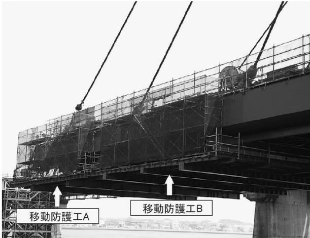
図-13 移動防護工（側径間）
