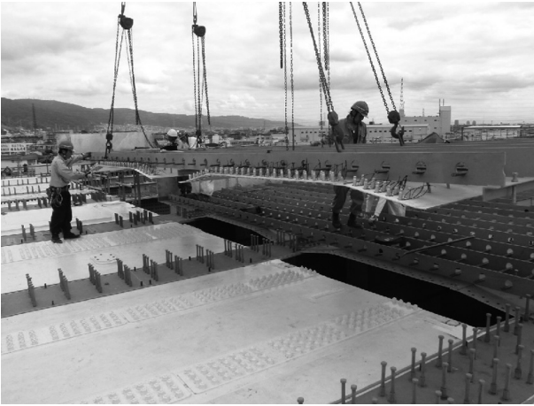
図-6 床版パネル架設状況
