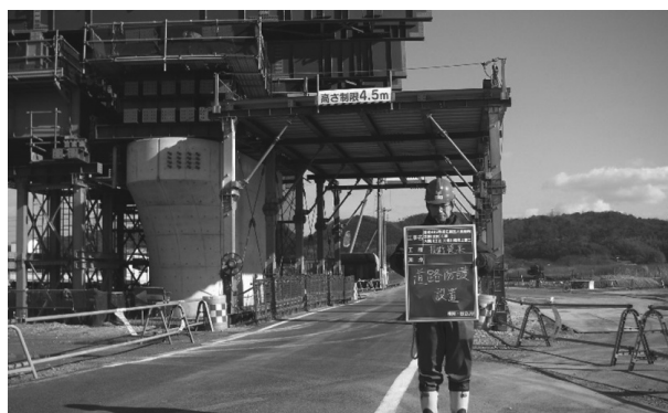
図-3 農道上の防護工
