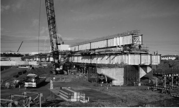
図-5 桁上ステージ上での桁組立
