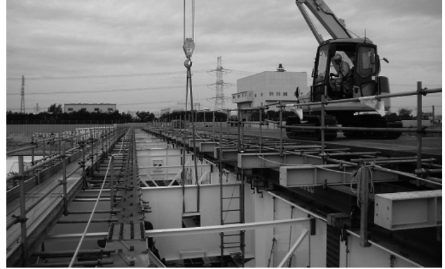
図-6 二次部材取付状況
