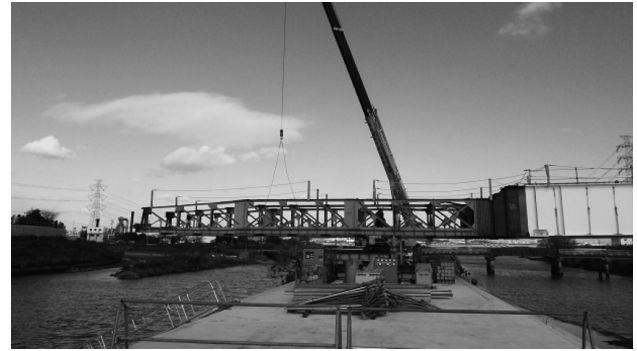
図-3 P4での手延べ機解体状況
