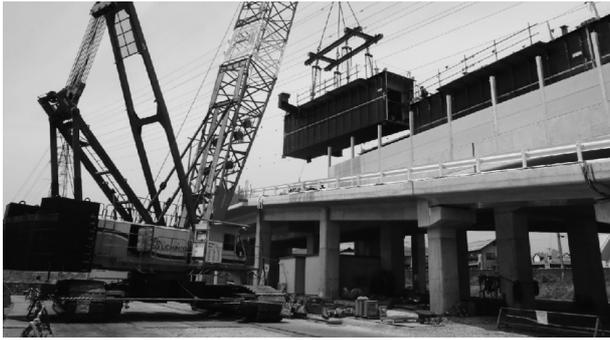
図-4 送だしヤード上への地組桁の架設
