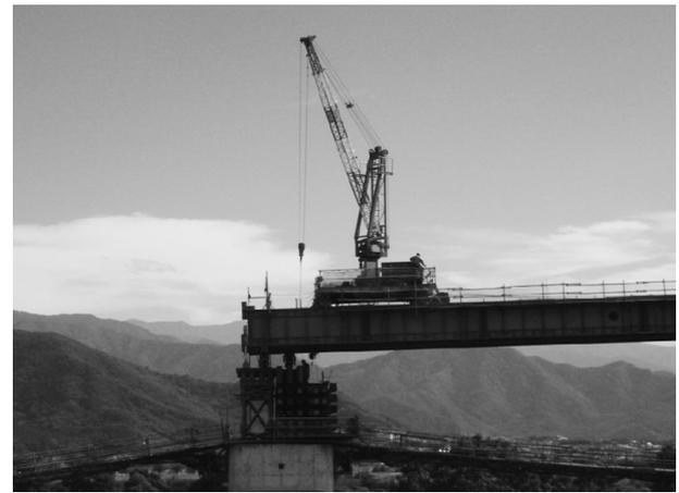
図-8 手延べ機上の移動式クレーン
