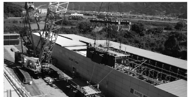
図-3 地組立作業専用の大型風防設備
