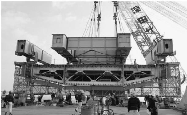
図-8 閉合部箱桁の大ブロックの架設（断面）
