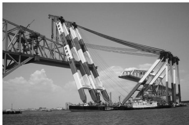
図-6 トラス部大ブロックの架設
