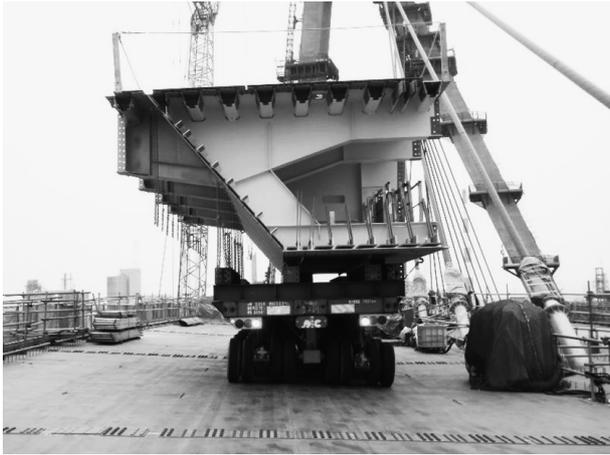
図-7 鋼桁運搬状況（外セル）
