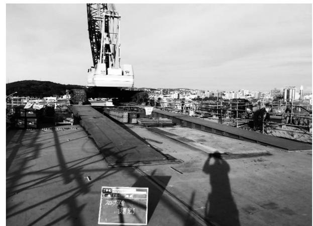
図-6 クレーン用スロープ架台
