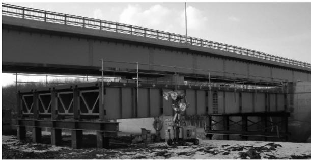
図-13 栈橋設置完了写真
