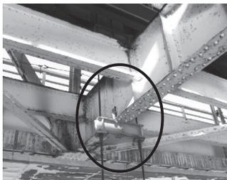
図-7 吊下げ設備
