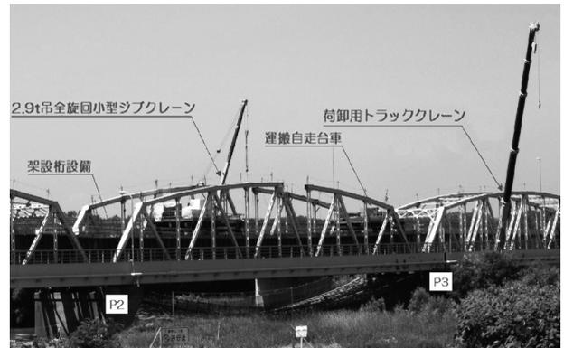
図-10 桁撤去状況 (P2～P3)
