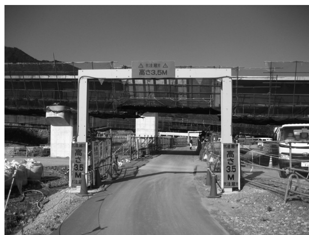
図-7 桁への衝突防止用高さ制限
