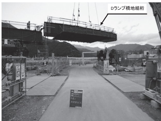
図-8 町道上の地組・架設状況
