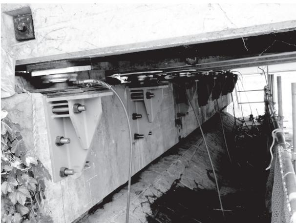
図-6 A2橋台側ジャッキ設備
