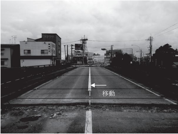
図-8 桁回転横移動完了
