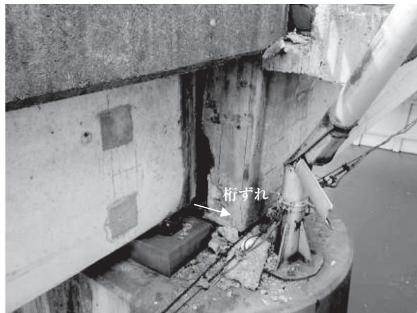
図-2 主桁の移動・断面欠損
