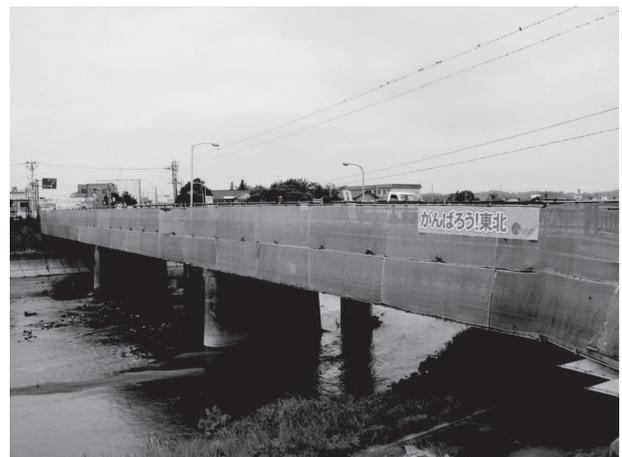
図-10 錦橋応急復旧工事全景
