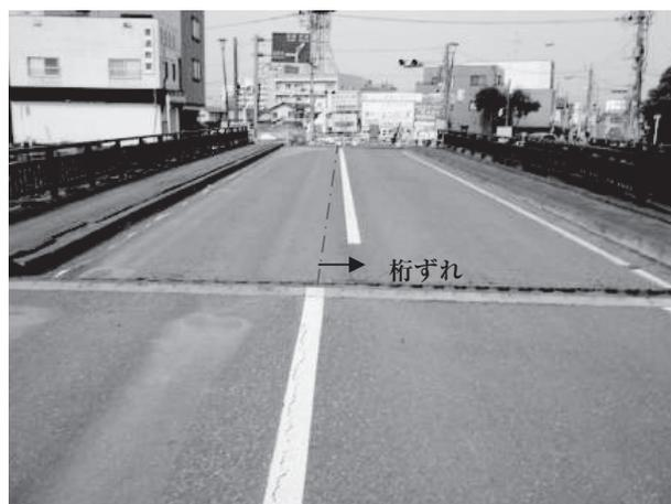
図-1 桁のずれ（第3径間）
