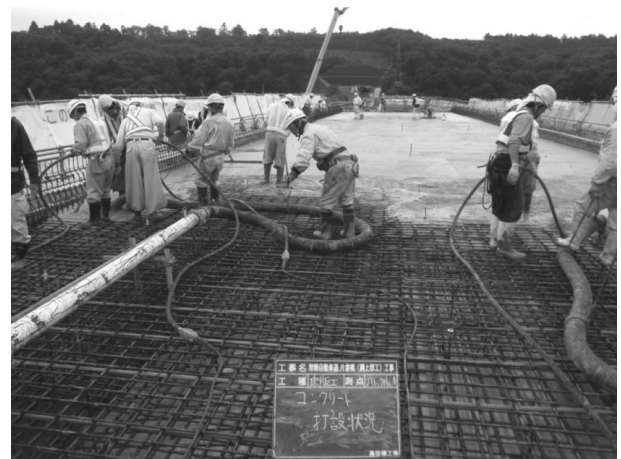
図-5 床版コンクリート打設状況
