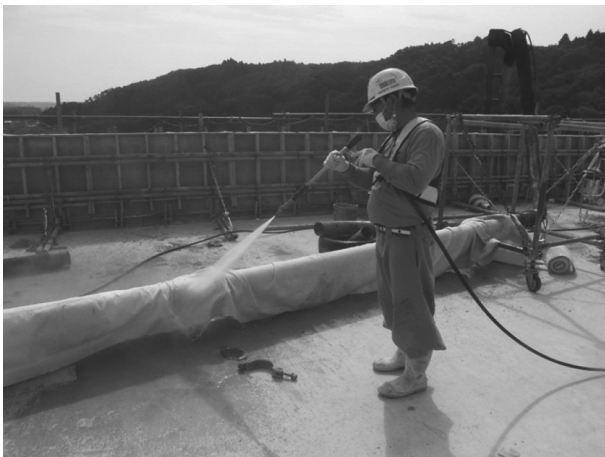
図-4 ポンプ配管の散水および養生
