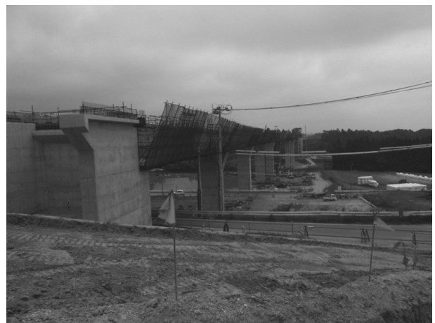
図-2 施工前（起点方より）
