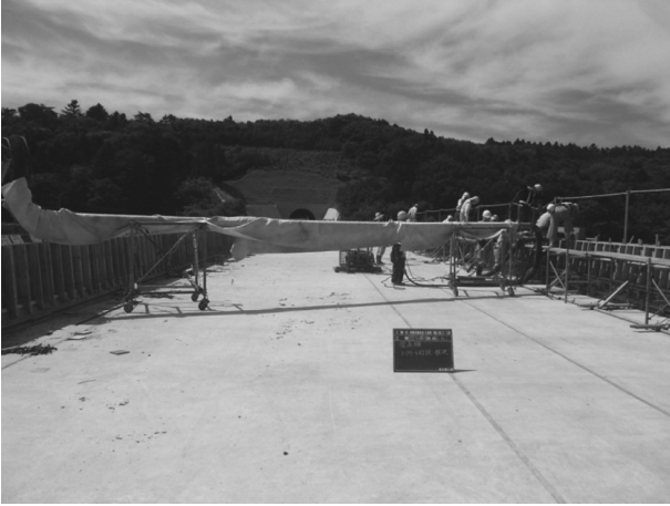
図-6 壁高欄コンクリート打設状況
