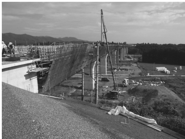
図-3 圧送試験状況
