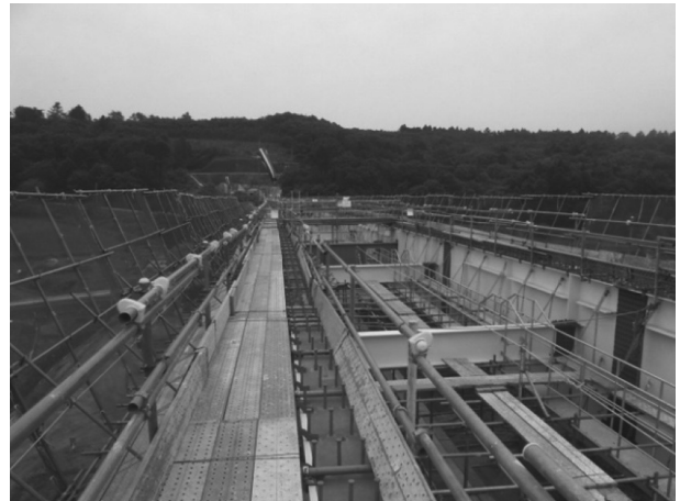
図-1 床版施工前
