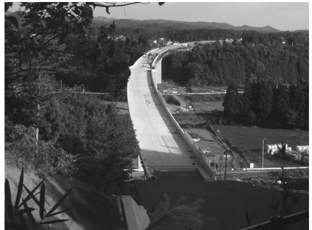
図-7 床版、壁高欄完成
