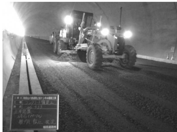
図-4 上層路盤における情報化施工
