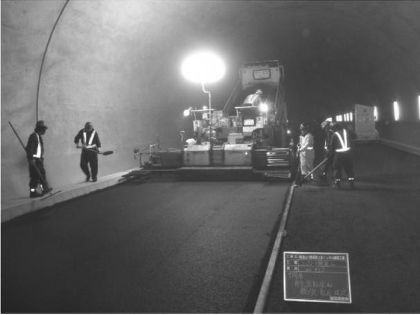
図-5 中間層の施工状況
