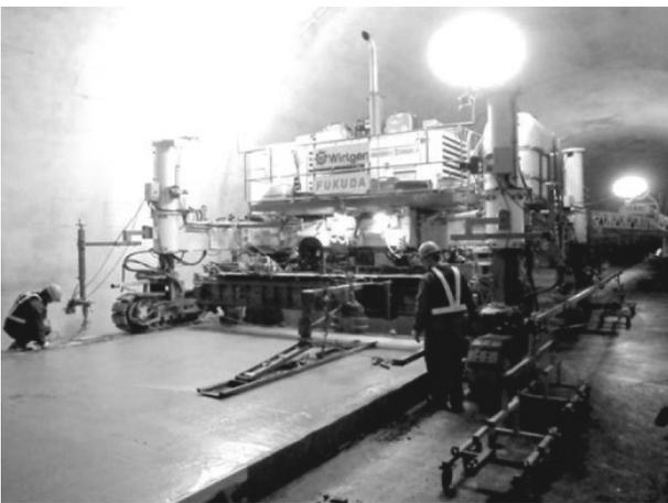
図-9 コンクリート打設状況（表面仕上げ）
