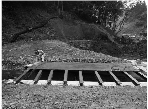
図-6 仮栈橋設置 H鋼+敷き鉄板
