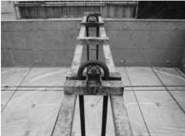
図-3 吊アンカー取付け用専用治具
