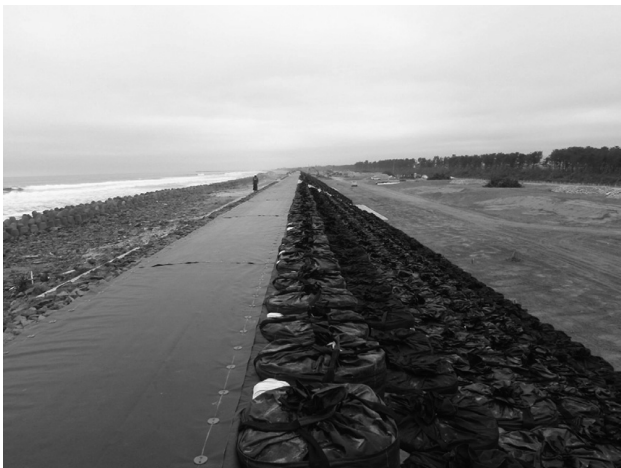
図-8 竣工時写真
