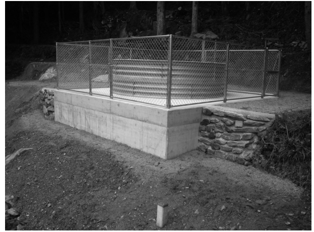
図-7 集水井完成
