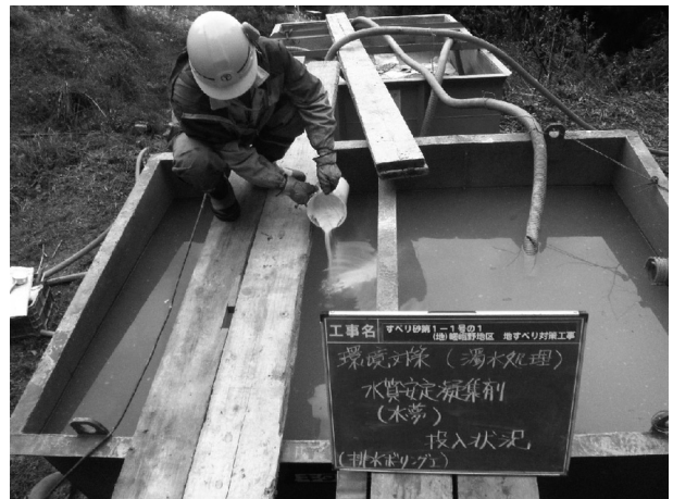
図-5 水質安定凝集剤の使用状況
