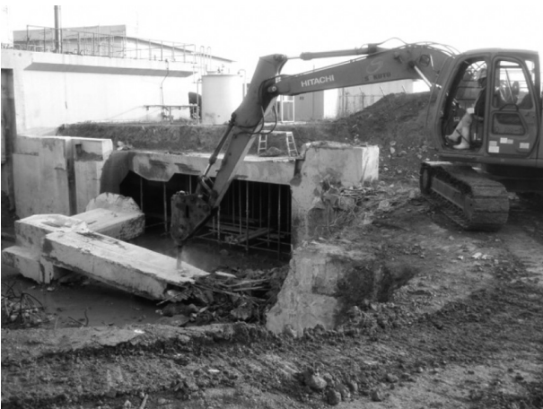
図-10 ワイヤソー切断後破碎状況
