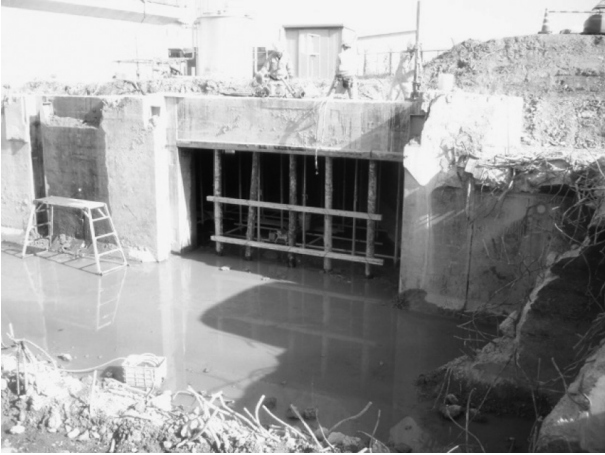
図-9 ワイヤソー切断前丸太補強
