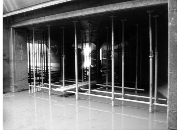
図-11 残置部分の補強
