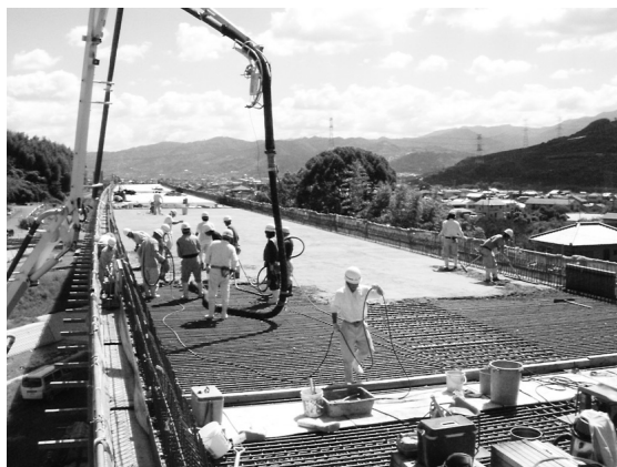
図-3 床版コンクリート打設状況
