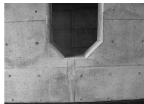
図-9 誘発目地の設置状況
