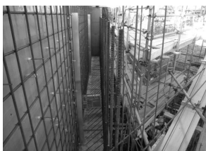
図-8 誘発目地の設置状況
